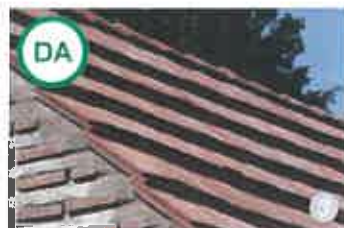
DA AȘA DA: Țigla nouă produsă manual după rețete tradiționale este soluția recomandată atunci când vorbim despre înlocuirea învelitorilor istorice degradate.
