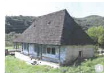
Casă cu pereți de lemn așezați pe un soclu construit din piatră
