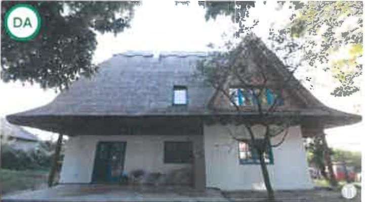
DA! AȘA DA: Acoperișul poate fi prevăzută cu aruncători pentru a îndepărta apa din apropierea zidului: casă în satul Feleacu.
