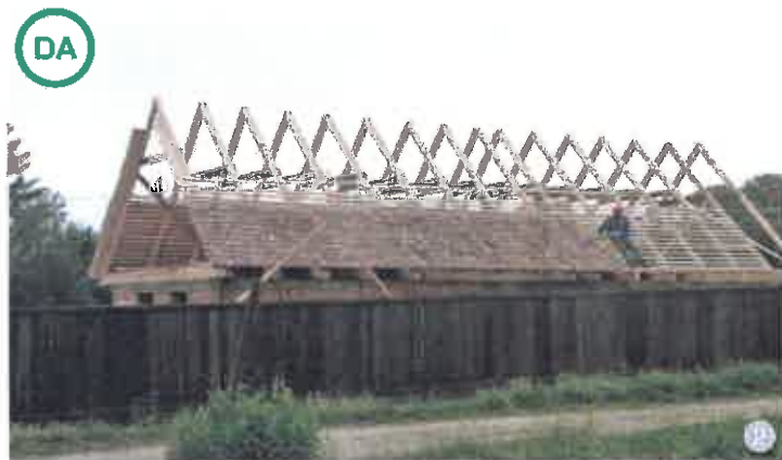
AȘA DA: Exemplul unei șarpante simple, un sistem care se folosește regulat în Transilvania.
