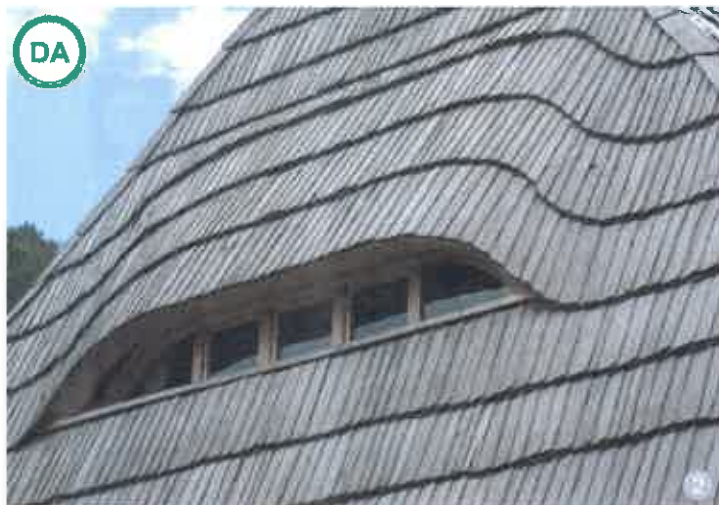
AȘA DA: Utilizarea unor învelitori ca șindrila, stuful sau țigla solzi permite realizarea unor lucrări foarte discret inserate în volumul acoperișului, care asigură necesarul de lumină și ventilație în spațiul mansardat.
