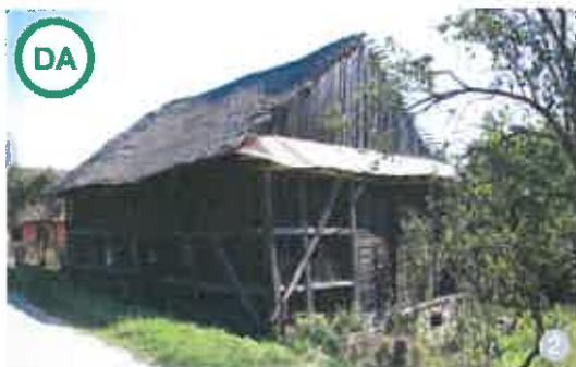
AȘA DA: Șură pe două niveluri: șură și grajd din piatră sub nivelul străzii și înălțat din lemn la nivelul străzii, în satul Panticeu
