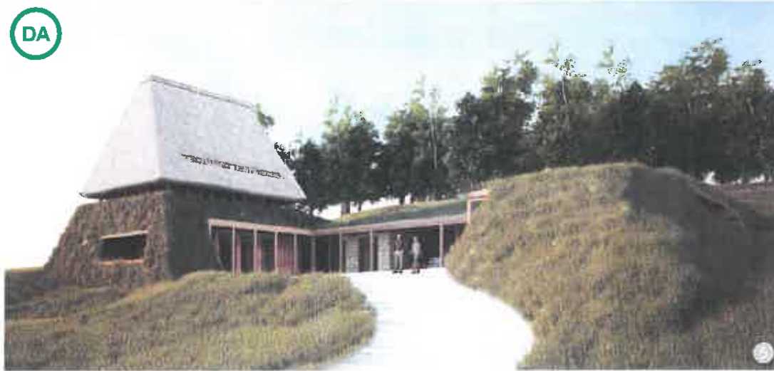
DA AȘA DA: Exemplu de utilizare a unor materiale compatibile la învelitoare: alăturarea unui acoperiș vegetal/verde celui acoperit cu stul/paie.
