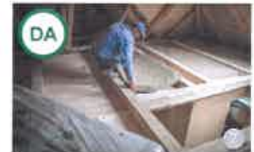
ASA DA: Termoizolația din lână este deosebit de recomandată. Folosirea unei izolații din lână sprijină o industrie a prelucrării produselor locale: în mod frecvent, lâna se aruncă, în loc să fie utilizată. Această măsură este încă la început în țara noastră, dar se folosește cu succes și pe scară largă în majoritatea țărilor europene.
