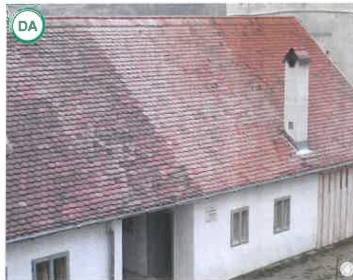
DA AȘA DA: Țigla nouă care respectă dimensiunile și forma celei tradiționale este recomandată la reabilitarea unei construcții existente.
