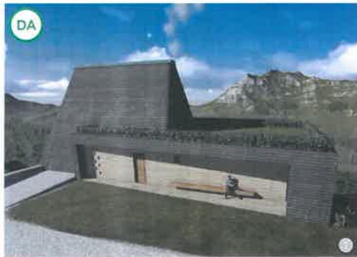
DA AȘA DA: Exemplu de utilizare a unor materiale compatibile la învelitoare - alăturarea unui acoperiș vegetal/verde celui acoperit cu șindriță.
