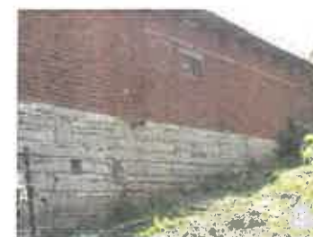
Casă cu pereți de cărămidă așezați pe un demisol construit din piatră
