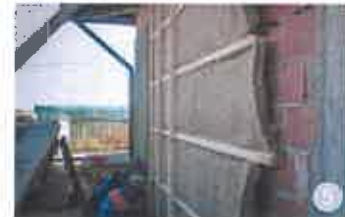
ASA DA: Termoizolația din lână este deosebit de recomandată. Folosirea unei izolații din lână sprijină o industrie a prelucrării produselor locale: în mod frecvent, lâna se aruncă, în loc să fie utilizată. Această măsură este încă la început în țara noastră, dar se folosește cu succes și pe scară largă în majoritatea țărilor europene.
