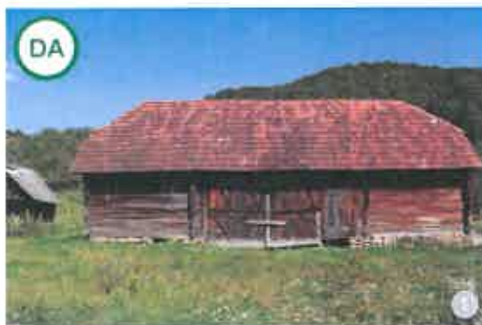
AȘA DA: Șură realizată din bârne de lemn, cu acoperiș în două ape și fronton teșit
