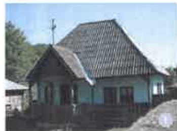
Înălțimea pereților mai mică decât înălțimea acoperișului
