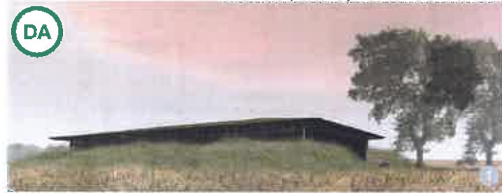
ASA DA: Acoperirea parțială și protejarea fațadelor de dimensiuni mari ale hătelor cu taluzuri de pământ acoperit cu vegetație, rezultat în urma escavărilor din timpul construirii obiectivului.
