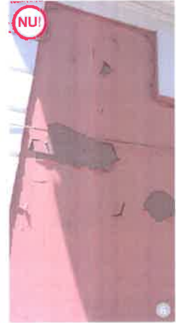
ASA NU: Este contraindicată folosirea unor zugrăveli acrilice pe clădirile tradiționale. Acestea nu aderă la zugrăveala pe bază de var originală și nu lasă pereții să respire. Decaparea lor în caz de degradare este dificilă.
