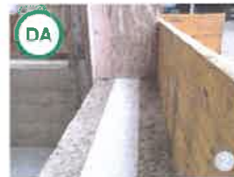
AȘA DA: Casă cu structură de lemn și pereți din amestec de cânepă cu var stins (hidraulic); denumirea materialului este Herrpcrete.
