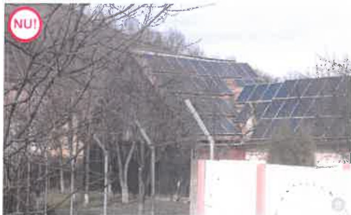
NU! AȘA NU: Nu se recomandă acoperirea a mai mult de 25 % din suprafața unui versant al acoperișului cu panouri fotovoltaice, deoarece acest lucru ar afecta într-un mod neplăcut imaginea de ansamblu a clădirii și a vecinătăților, așa cum se poate observa în exemplul din imaginea 8.
