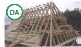
AȘA DA: Șarpantă nouă cu lucrare
