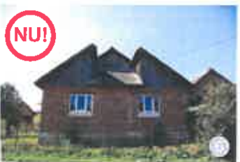
NU! AȘA NU: Panta acoperișului este atipică și ineficientă din punctul de vedere al elementelor de lemn folosite.
