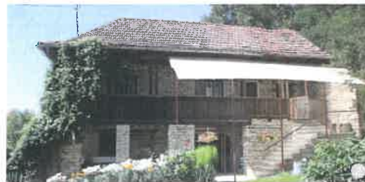
Pereți masivi din piatră, stă la nivelul demisolului, cât și al parterului
