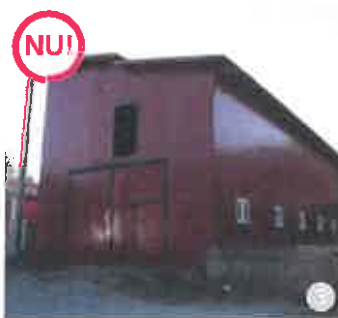
ASA NU: Se interzice, pentru orice tip de construcție, folosirea unor finisaje metalice exterioare pe suprafețe mari, precum tabla industrială. Se acceptă finisarea metalică pe suprafețe foarte mici, atunci când fluxul tehnologic sau condițiile obiective de altă natură o impun.
