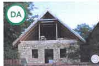
AȘA DA: Exemplu de șarpantă nouă rezolvată corect peste o șură existentă din satul Chiclea.
