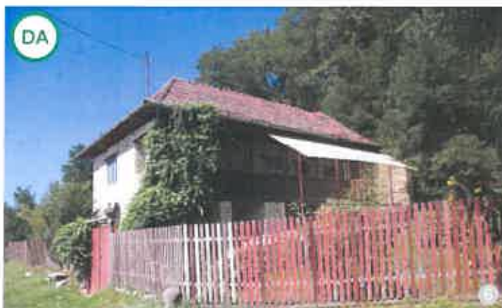
Acoperiș în trei ape cu învelițoare din țiglă ceramică trasă, în satul Giula
