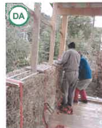
AȘA DA: Casă cu structură din lemn și pereți din baloți de paie sau pereți din blocuri de argilă amestecată cu paie.
