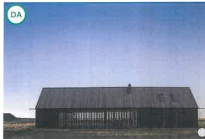
ASA DA: Necesitatea de lumină poate constitui un factor decisiv în arhitectura fațadelor. Pereții vitraji pot fi dublați de un element de umbrire din lemn, care trimite la detaliile de închidere a construcțiilor tradiționale.
