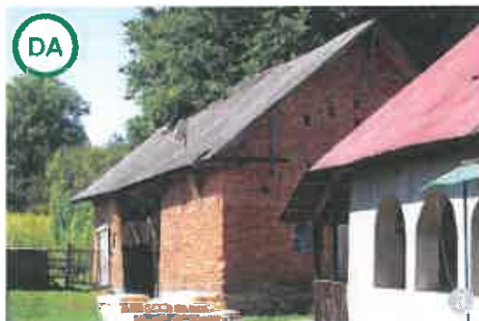
AȘA DA: Șură din cărămidă aparentă, cu acoperiș în două ape și fronton triunghiular, în satul Sărata
