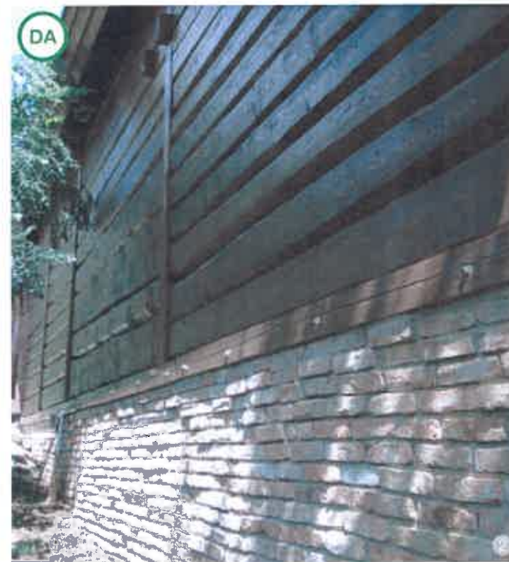
ASA DA: Materialele de construcție tradiționale, precum cărămida și lemnul, pot fi puse în operă într-o modalitate contemporană, îndeplinind standardul de confort actual.
