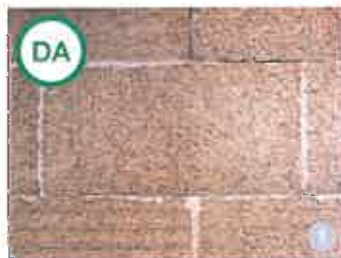
AȘA DA: Casă cu structură de lemn și pereți din amestec de cânepă cu var stins (hidraulic); denumirea materialului este Herrpcrete.
