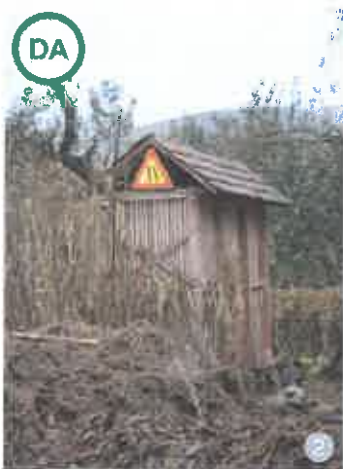
ASA DA: Casaș nou care păstrează volumetria și materialele tradiționale
