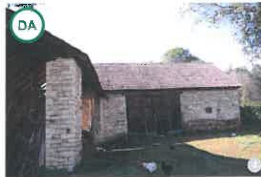
AȘA DA: Șură de mari dimensiuni, realizată din piatră, cu acoperiș în două ape și fronton triunghiular, în satul Chidea
