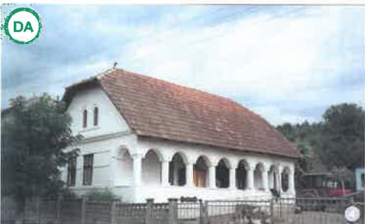
Acoperiș în două ape cu învelițoare din țiglă ceramică, cu fronton teșit de influență barocă. Acest tip de acoperiș se găsește pe tot cuprinsul zonei studiate, preponderent în cazul locuințelor.
