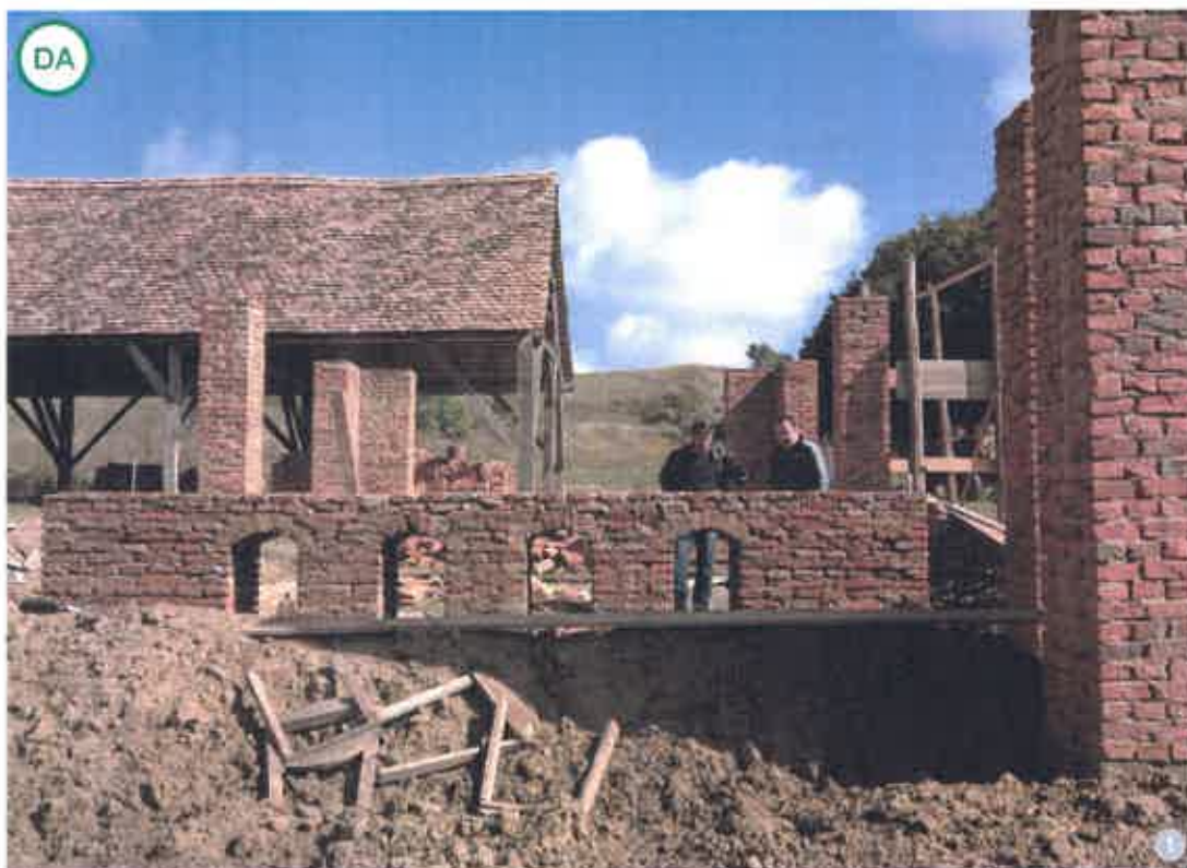
ASA DA: Construcție nouă cu pereți și stâlpi din cărămidă și beton: cărămida tradițională, prin dimensiunile ei mici, se adaptează ușor la orice configurație planimetrică, chiar și în detalii.
