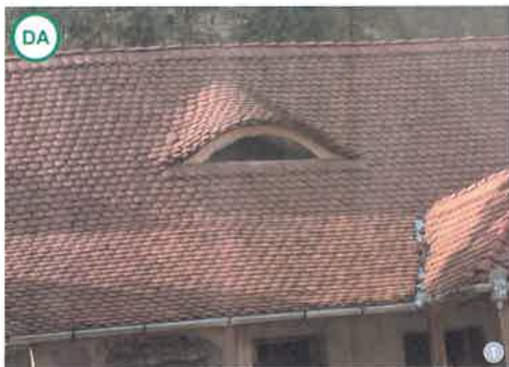
AȘA DA: Lucramele de tip „ocul de pisică” sunt folosite pentru a ilumina un pod mansardat. Acestea modifică nesubstanțial volumul acoperișului.
