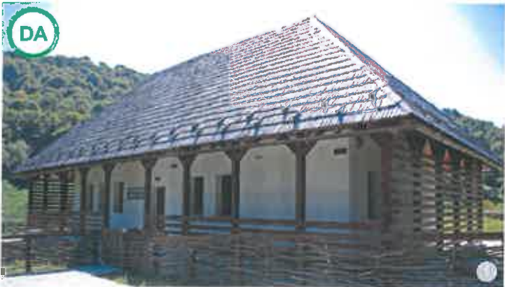
AȘA DA: Acoperiș realizat cu materiale și tehnici tradiționale locale: proiect realizat cu finanțare europeană în satul Vad.
