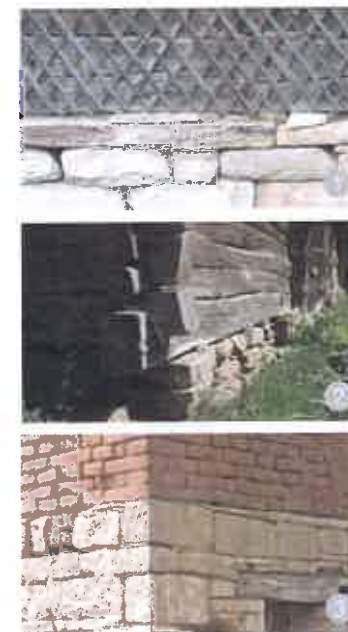
Fundațiile erau realizate din piatră atât la construcțiile din lemn, cât și la cele din cărămidă.
