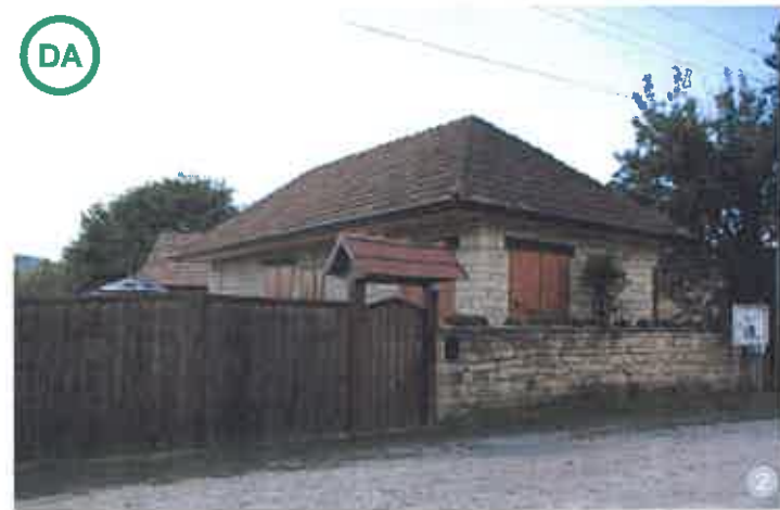
AȘA DA: Pe latura pe care se intră în casă, streășina poate fi mărită, pentru a proteja accesul. Aceasta este o soluție arhaică, promergătoare apariției târnațului.
