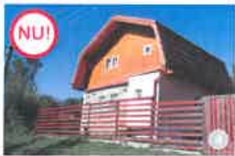
NU! AȘA NU: Nu se recomandă adoptarea unor forme de acoperiș neobișnuite.
