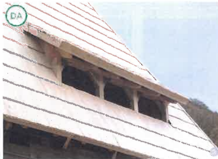
AȘA DA: Lucrarea prelungită într-o singură apă piscină, ca din imagine este o soluție stabilă de iluminare a mansardei.
