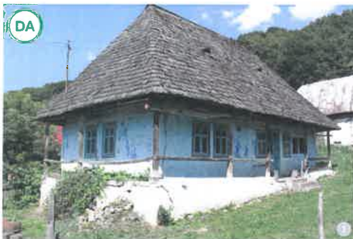
Acoperiș în patru ape cu învelițoare din șindriță (șifă); imagine din satul Sălătruc
