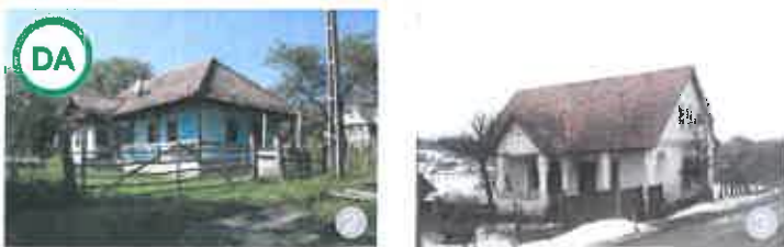
Acoperiș în patru/două ape cu foisor și învelițoare din țiglă ceramică trasă. Acest tip de acoperiș apare preponderent în partea de nord a zonei studiate.
