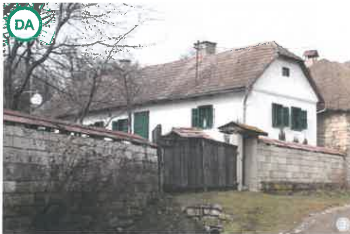
AȘA DA: Casă de locuit tradițională restaurată
