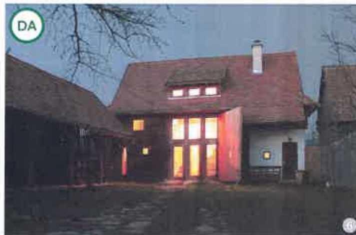
ASA DA: Șura veche a fost reconstruită din materiale noi, păstrându-se forma șurii vechi. La interior s-au păstrat organizarea spațială și structura originară de lemn. Pentru iluminarea spațiului din mansardă, deasupra porții s-a construit un rând de lucame.
