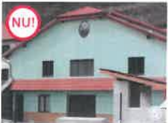
NU! AȘA NU: Panta acoperișului este atipică și ineficientă din punctul de vedere al elementelor de lemn folosite.
