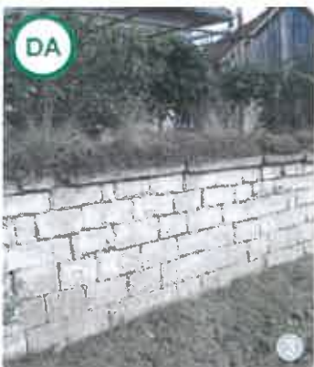
ASA DA: Exemplu de împrejmuire din satul Chidear: zidărie din piatră peste care s-a pus un capac tot din piatră, pământ și plante.
