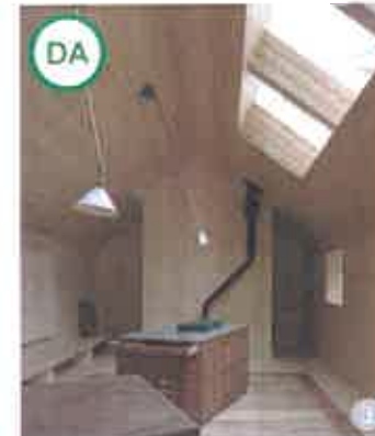
AȘA DA: Casă cu structură din panouri de lemn lamelar încleiat; denumirea materialului este GLT (Cross-laminated timber)
