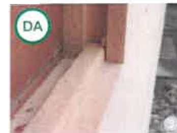
ASA DA: Termoizolație fibrolemnoasă. Produs fabricat din materii prime naturale, utilizând tehnologii moderne și prietenoase cu mediul. Fiind permeabilă la vaporii de apă, păstrează structura casei în stare uscată în mod permanent. Poate fi utilizată pentru fațadă, pardoseli și mansarde.
