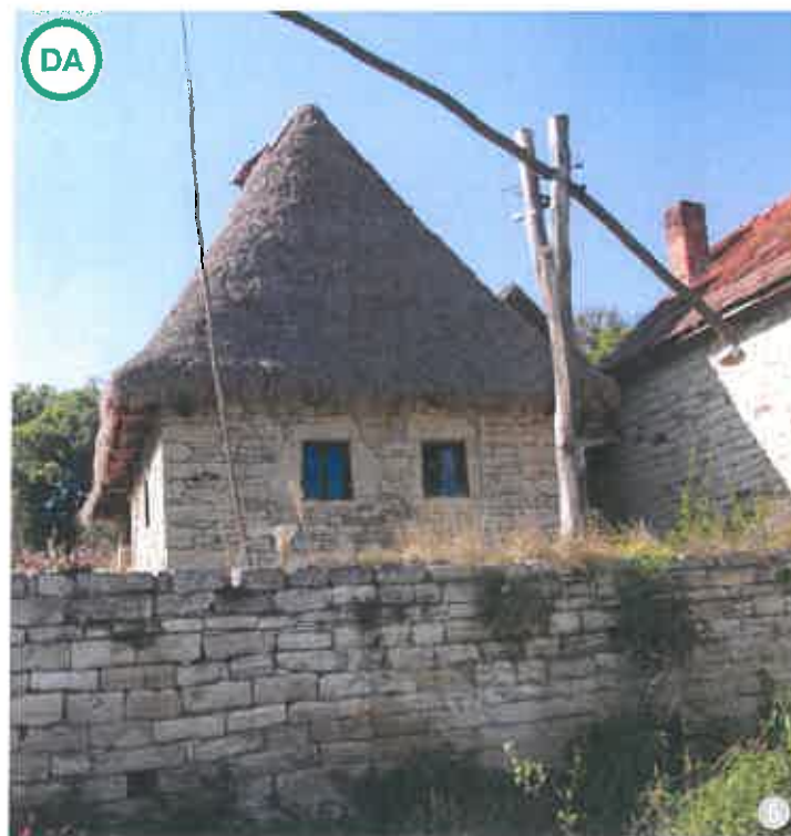
Acoperiș tradițional în patru ape cu învelițoare din paie; în imagine, casă din satul Chidea. Acest tip de învelițoare era cel mai răspândit în trecut.
