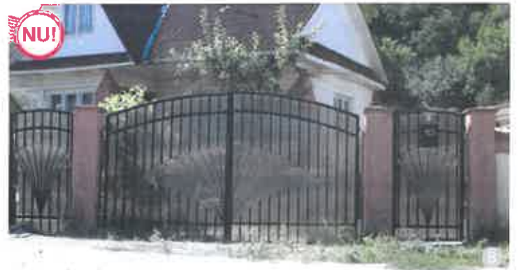
AȘA NU: Înlocuirea porții din lemn cu una metalică, placată cu policarbonat, este nerecomandată, pentru că are o durată scurtă de viață. Aceasta din urmă este inadecvată din punct de vedere estetic, zgomotoasă și nu asigură intimitate, din cauza transparenței materialului.
