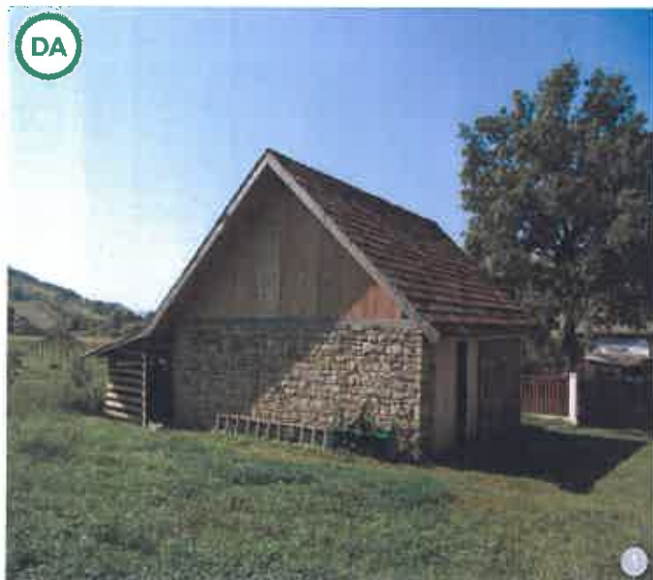
ASA DA: Șură reparată corect și relucronalizată: zidăria a fost reparată, acoperișul refăcut cu țiglele originare și șarpanta a fost consolidată cu elemente noi; ea se încadrează perfect în peisajul gospodăriei.
