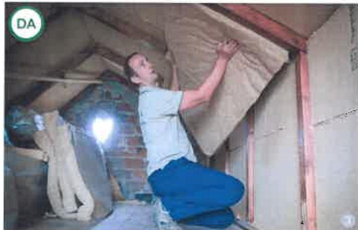
ASA DA: Termoizolația din cânepă: montare rapidă și simplă. Nu este necesar un costum de protecție, deoarece produsul nu irită pielea și nu conține substanțe periculoase pentru mediu sau sănătate.
