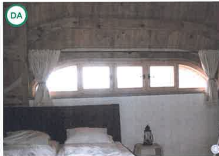
AȘA DA: Utilizarea unor învelitori ca șindrila, stuful sau țigla solzi permite realizarea unor lucrări foarte discret inserate în volumul acoperișului, care asigură necesarul de lumină și ventilație în spațiul mansardat.
